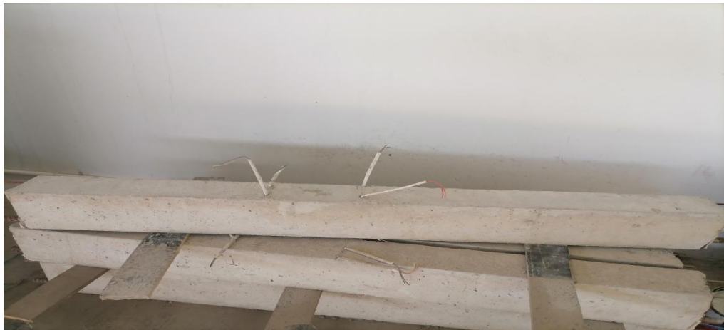
图 3 混凝土梁实物图
